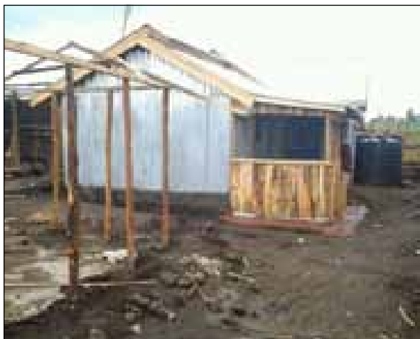
Aufbau des neuen Elternhauses von Gikuni
