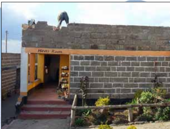
Renovierungsarbeiten am Dach des Camps
