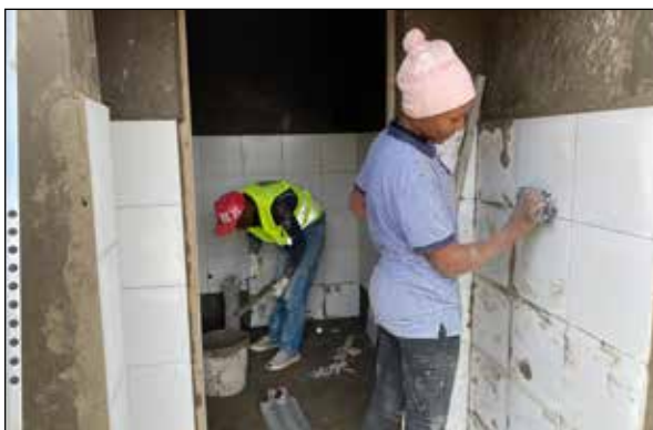
Die neue Toiletanlage wird selbstverständlich auch verfließt
